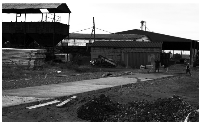
Бетонируются подъездные пути
